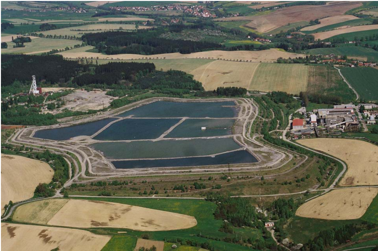
Obr. 1: Odkaliště K 1, chemická úpravna
