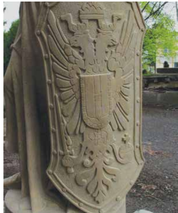
Obr. 11: Kopie sochy Austrie - detail erbu po ručním opracování.
