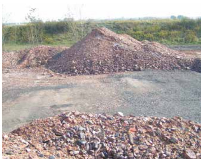
Obr. 5. Val vytvořený k ochlazení horninového materiálu.
