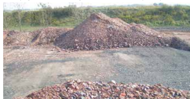
Rys. 7. Pryzmy tworzone dla wychłodzenia materiału skalnego.
