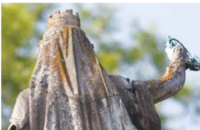
Rys. 2. Austria – oryginał – figura przed zdemontowaniem – pęknięcie w obszarze pleców, wtórne interwencje, zanieczyszczenia biologiczne.
