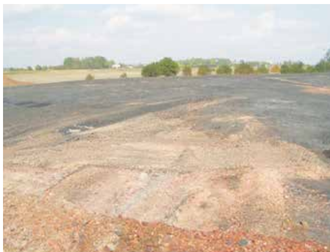
Obr. 6. Povrch haldy po dotvarování a zhutnění.
