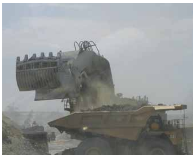
Obr. 9: Lopatové rypadlo 11,5 m 3 při vykládce zeminy do dampru.
