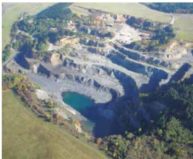
Fot. 1. Położenie kamieniołomu Kosov z południowo-zachodniej strony (autor Petr Pánek)
