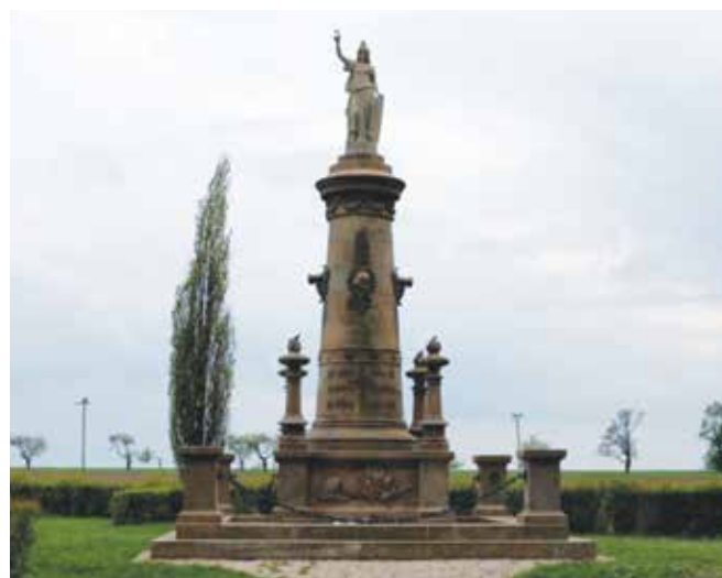
Rys. 15. Całościowy widok pomnika Baterii Poległych po umieszczeniu kopii (fot. J. Paclík)
