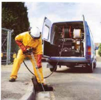
Obr. 4: Aplikace vodního paprsku s ručním nářadím.
