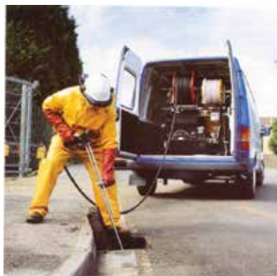
Rys. 4. Zastosowanie cięcia strumieniem wodnym z użyciem narzędzi ręcznych.
