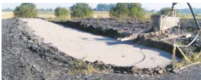
Rys. 3. Rów chłonny wypełniony pyłem dymnicowym oddzielający część zachodnią hałdy na której był pożar, od niezapożarowanej części wschodniej.
