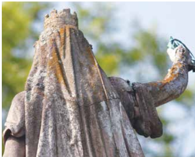
Obr. 2: Originál Austrie - socha před demontáží - prasklina v zádové partii, druhotné zásahy, biologické napadení (foto J. Paclík).
