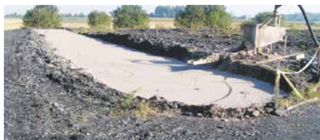
Obr. 3: Absorpční příkop vyplněný jílem, který odděloval západní hořící část haldy, od neshořelé východní části.
