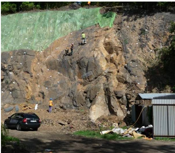
Obr. 4 Zajištění svahů (zdroj: www.vertico.cz )
