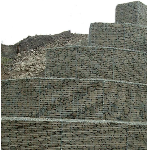
Obr. 5 Terasy vytvořené z gabionových košů (zdroj: www.sanap.cz )
