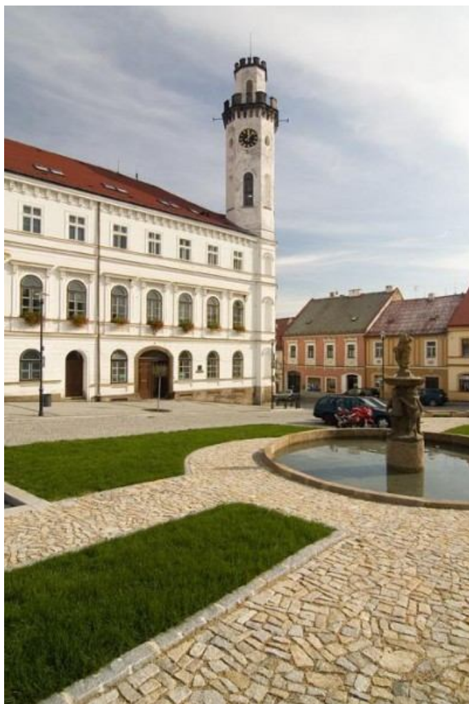
Obr. 4. Štěťová dlažba Klášterec nad Ohří
