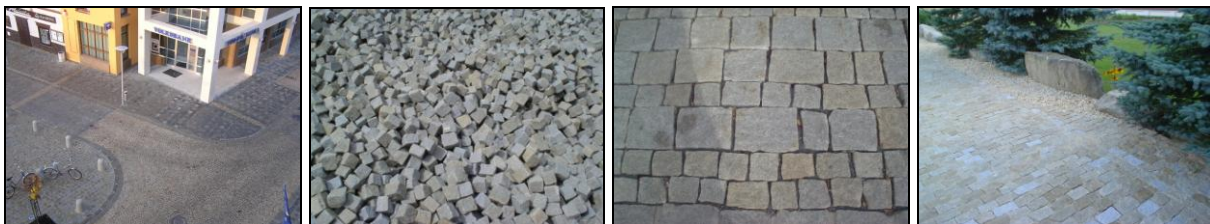
Obr. 2, 3, 4, 5 Ukázky silničního stavebního programu
