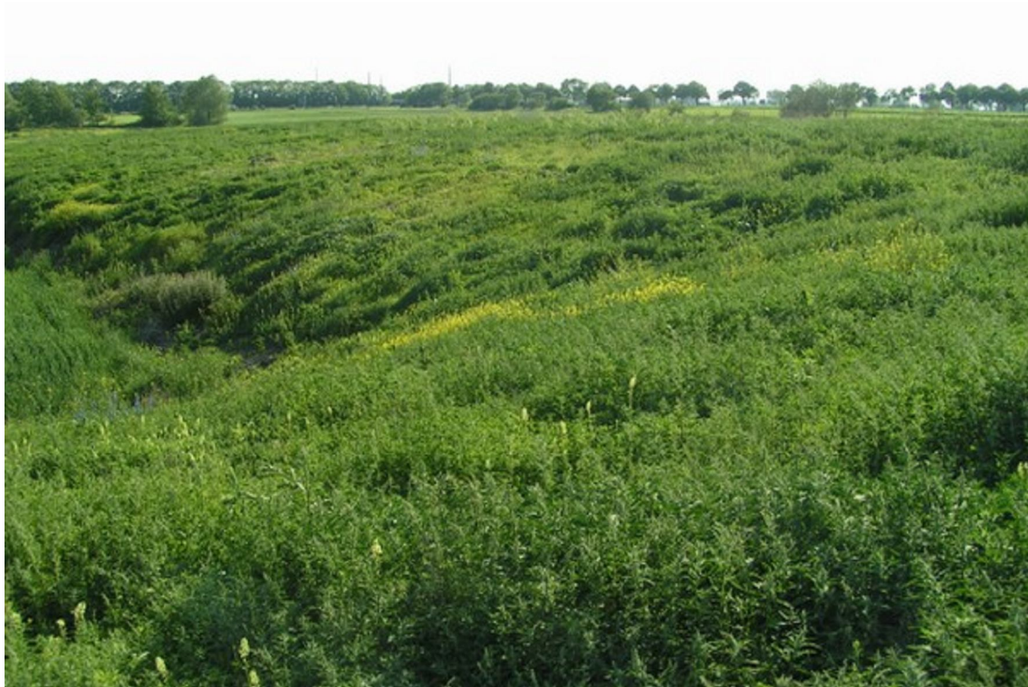
Rys. 10. Rekultywacja biologiczna - na zwałowisko wróciła roślinność.
