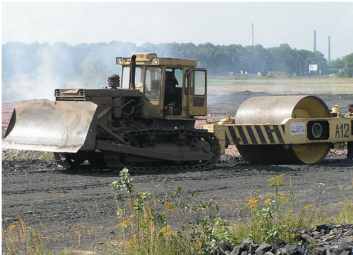
Rys. 8 Zagęszczanie materiału zwałowego.
