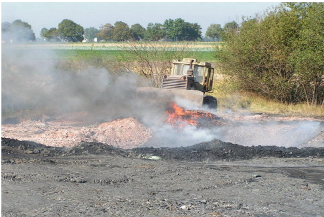
Rys 6. Praca spychacza – mieszanie materiału skalnego nieprzepalonego i przepalonego.
