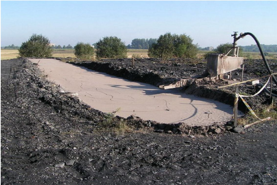
Rys. 3 Rów chłonny wypełniony pyłem dymnicowym oddzielający część zachodnią hałdy na której był pożar, od niezapożarowanej części wschodniej.
