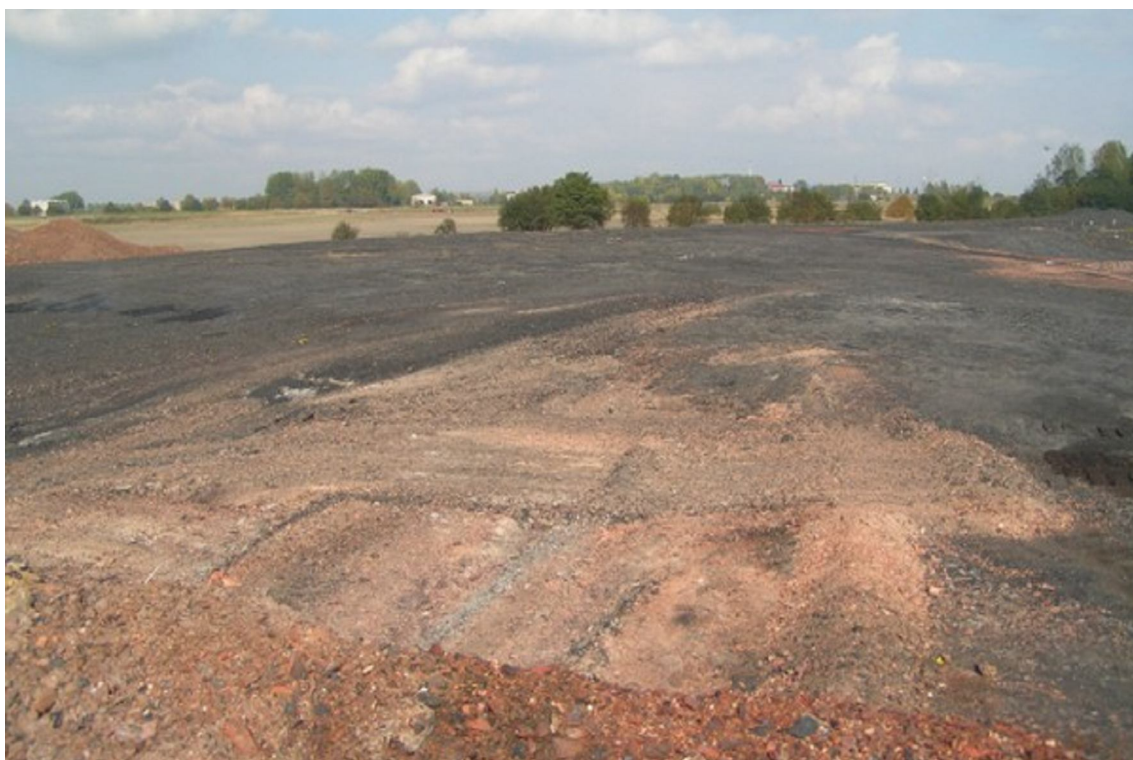
Rys 9. Powierzchnia zwałowiska po uformowaniu i zagęszczeniu.
